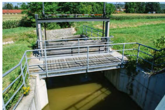
Schutzmaßnahme: Ein neu errichtetes Sperrwerk im Mühlkamp soll den Fluss bei Hochwassergefahr vom Ort absperren.
